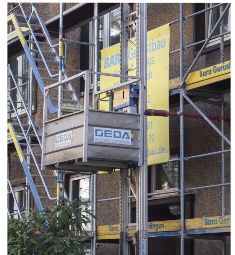
1 Het aluminium platform is 90° draaibaar. 2 De GEDA 200Z is geschikt voor vervoer van klein bouw materieel.
