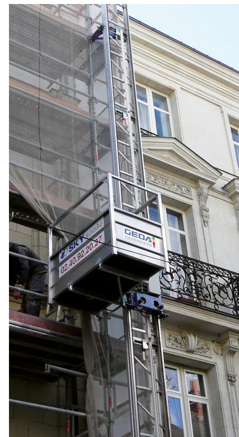
1 Het aluminium platform is 90° draaibaar. 2 De GEDA 200Z is geschikt voor vervoer van klein bouw materieel.
