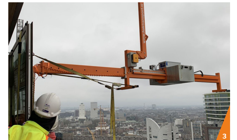
1 Hefsteiger opbouwen met behulp van evenaar uitgerust met hijshaak 2 Nieuwe omhulsels plaatsen met custom made hijsvoorziening op project De Schiecentrale in Rotterdam-Lloydkwartier 3 Beglaasd kozijn plaatsen onder overstek
