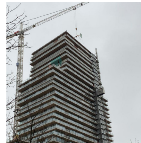
1 Hefsteiger opbouwen met behulp van evenaar uitgerust met hijshaak 2 Nieuwe omhulsels plaatsen met custom made hijsvoorziening op project De Schiecentrale in Rotterdam-Lloydkwartier 3 Beglaasd kozijn plaatsen onder overstek
