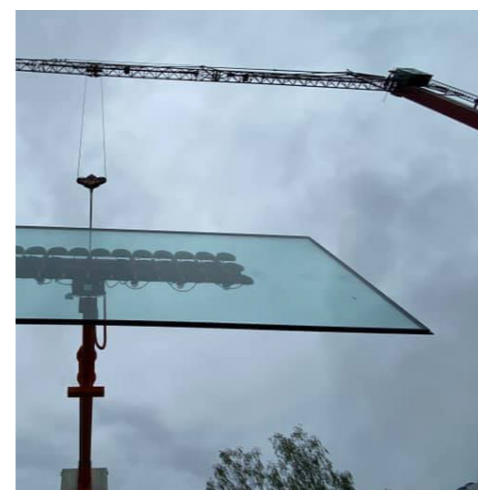
1 Bouwmaterialen aanleveren met behulp van evenaar uitgerust met hijshaak 2 Stalen frame plaatsen op een hoogbouwproject in Engeland 3 Groot formaat ruit plaatsen onder overstek op een project in Zwitserland
