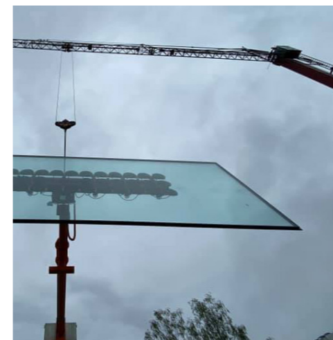
1 Zwaargewicht evenaar met demontabele ballastgewichten van 50,0 kg 2 Dit is bij uitstek de evenaar voor inzetten in de betonbouw 3 Groot formaat ruit plaatsen onder overstek op een project in Zwitserland
